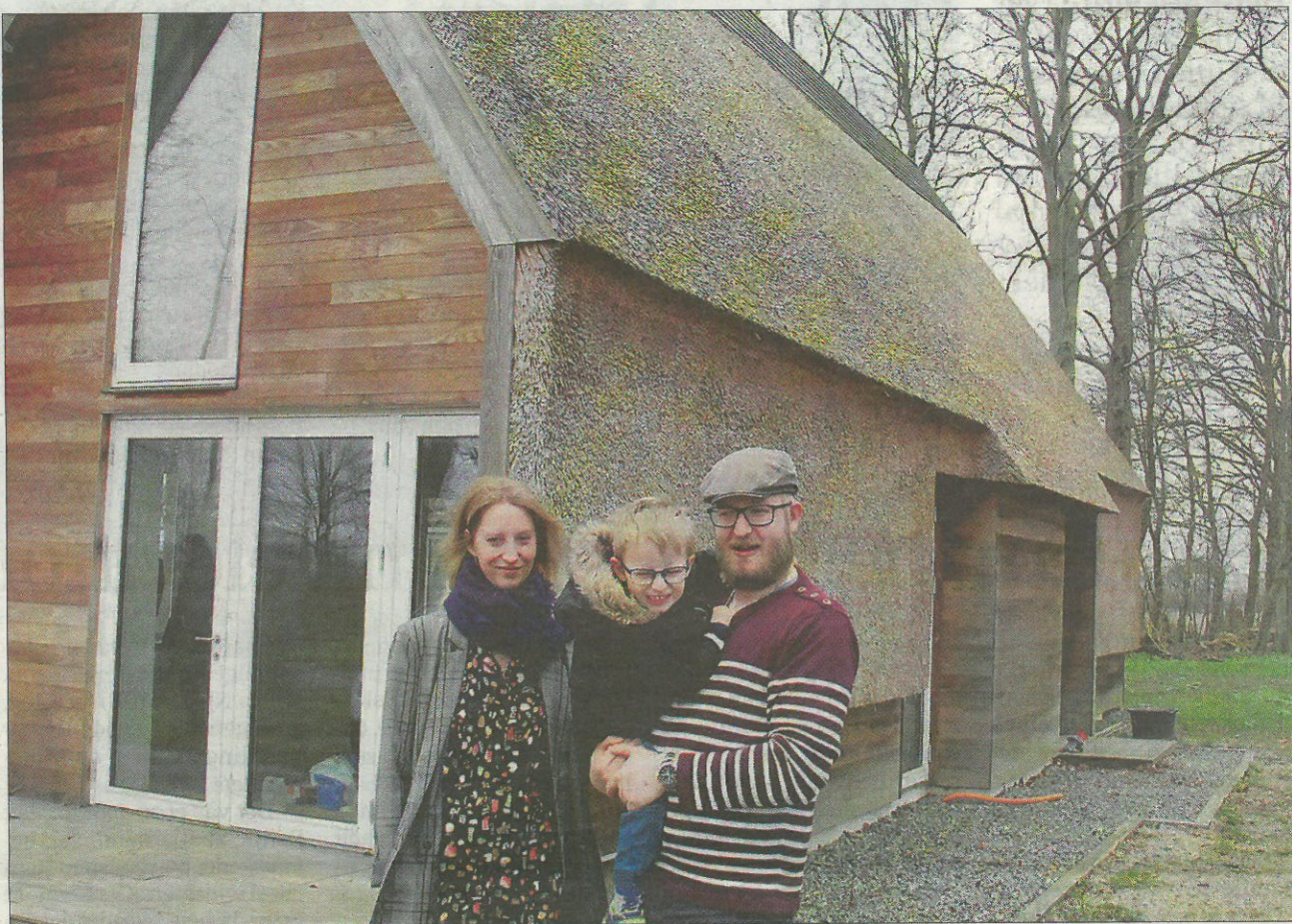
Huset er bygget af 100 procent organiske materialer. Som det ses er det beklædt med strå udvendig.
