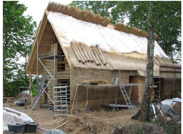
Stråtaget under udførelse
