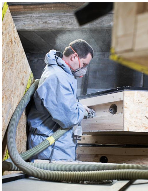
Papirisolering blæses ind i præfabrikerede elementer (t.v.), og i de første lukkede kasser i Det Åndbare Hus (t.h.)
