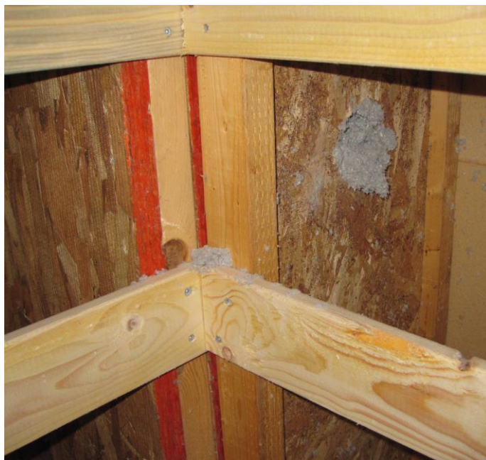
Papirisolering blæses ind i præfabrikerede elementer (t.v.), og i de første lukkede kasser i Det Åndbare Hus (t.h.)
