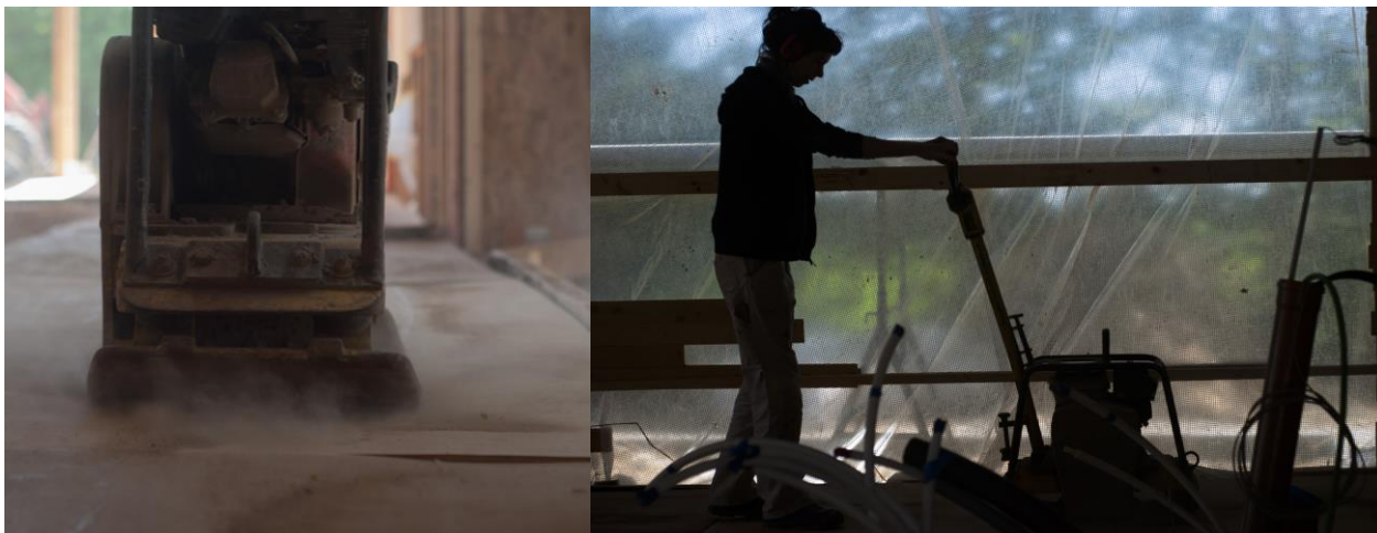
Komprimering af lergulv: Ler er lagt ud, rettet af, der er lagt plader på og vibratoren kører i Det Åndbare Hus Foto: Martin Volmer
