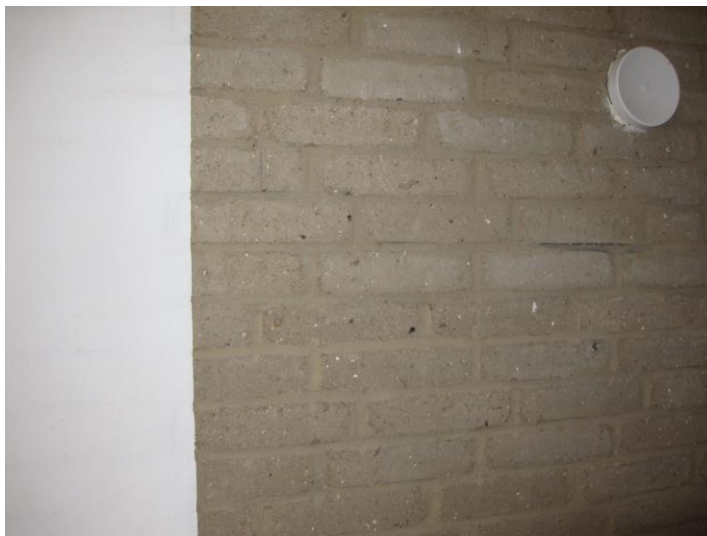
En rå lerstensvæg uden puds grænsende op til en malet lervæg
